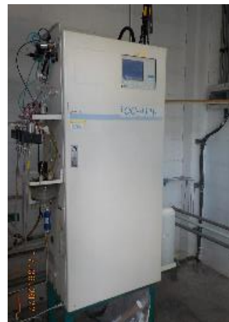
TOC online analyzer (โรงงานที่ 2)
