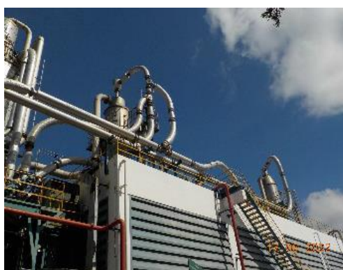
ภาพถ่ายที่ 2.2-15 อุปกรณ์ที่ใช้ลดระดับเสียงที่แหล่งกำเนิด
