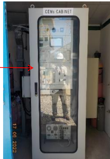
ภาพถ่ายที่ 2.2-2 อุปกรณ์ตรวจวัดก๊าซออกไซด์ของไนโตรเจนอัตโนมัติที่ปล่อง Effluent Incinerator (G-920W)
