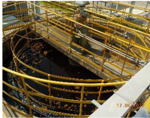
Sludge Thickener (โรงงานที่ 2)
