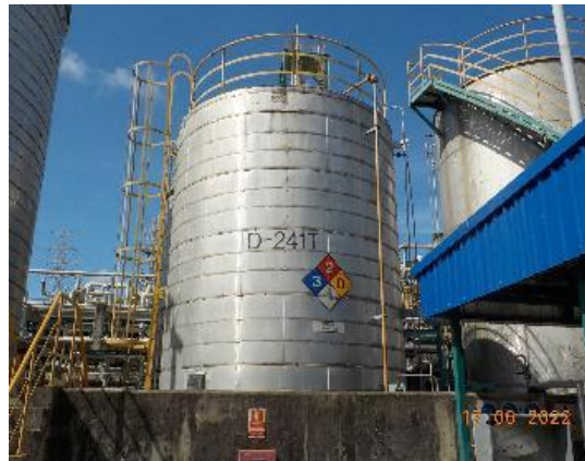
ภาพถ่ายที่ 2.2-10 ถังเก็บฟอร์มาลีนเจือจาง (D-241T)
