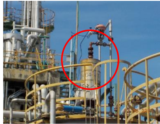
ภาพถ่ายที่ 2.2-5 Vent Cooler ที่หัวถังเก็บกักสารระเหย ที่มีเบนซิน
