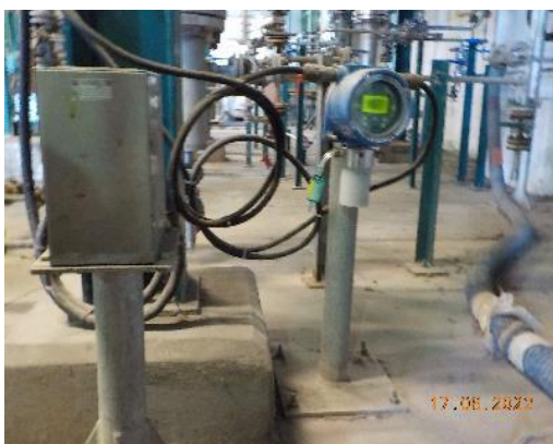
ภาพถ่ายที่ 2.2-26 Benzene Gas Detector
