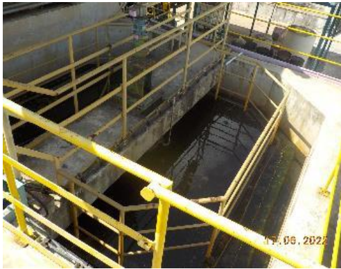
Sludge Thickener (โรงงานที่ 1)
