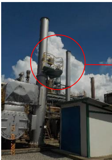
ภาพถ่ายที่ 2.2-2 อุปกรณ์ตรวจวัดก๊าซออกไซด์ของไนโตรเจนอัตโนมัติที่ปล่อง Effluent Incinerator (G-920W)
